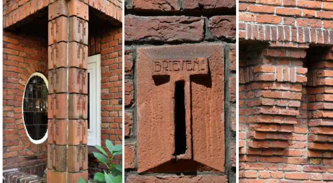
Details van metselwerk.
