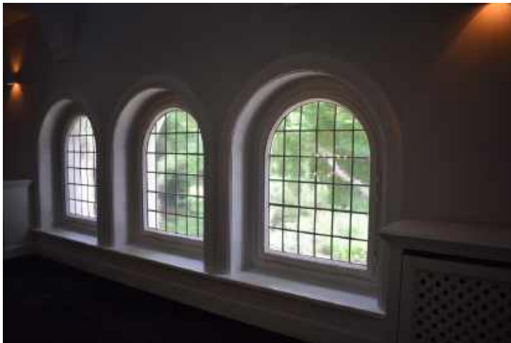
Daglichttoetreding op de verloop in het trappenhuis
